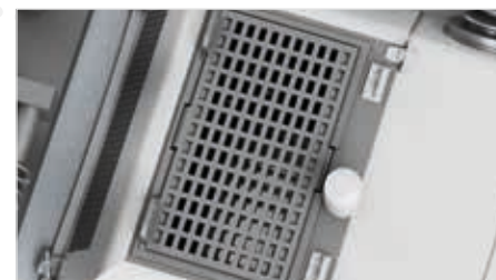
Rejillas de ventilación perforadas en el techo
