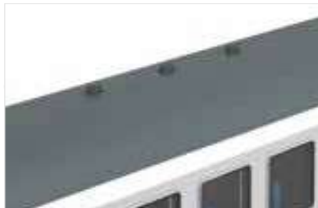
Separat angesetzte WLAN-Antennen
